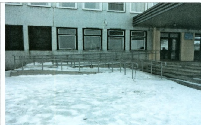
Фото №6 - Лестница наружная, вход в здание, пандус наружный
