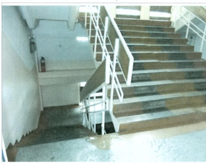
Фото №12 – Лестница (внутри здания)
