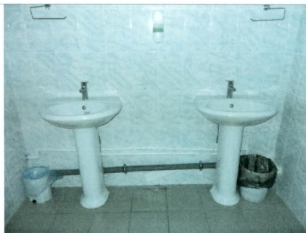
Фото №19- туалетная комната
