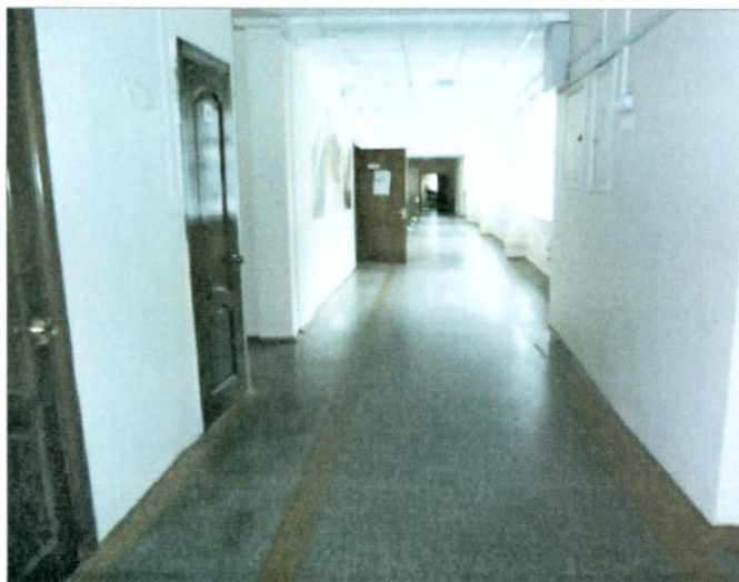
Фото №11 – Коридор (вестибюль, зона ожидания, галерея, балкон)
