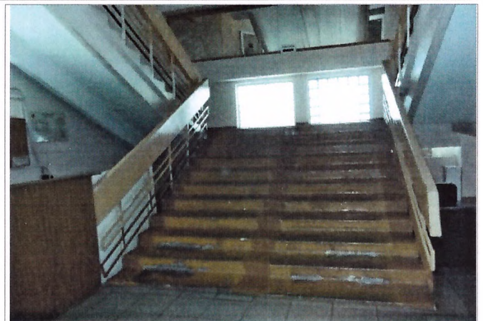
Фото №14 – Лестница центральная (внутри здания)
