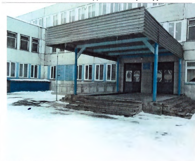
Фото №9 – вход в здание
