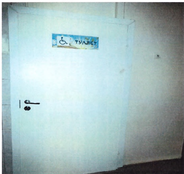
Фото №27 – Туалетная комната
