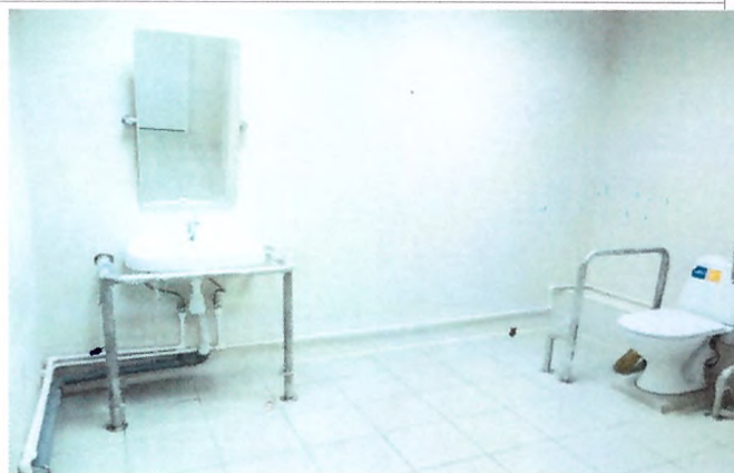
Фото № 29 – Туалетная комната
